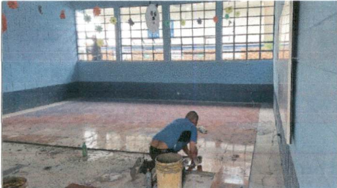
Foto 3: Sustitución de piso de granito
