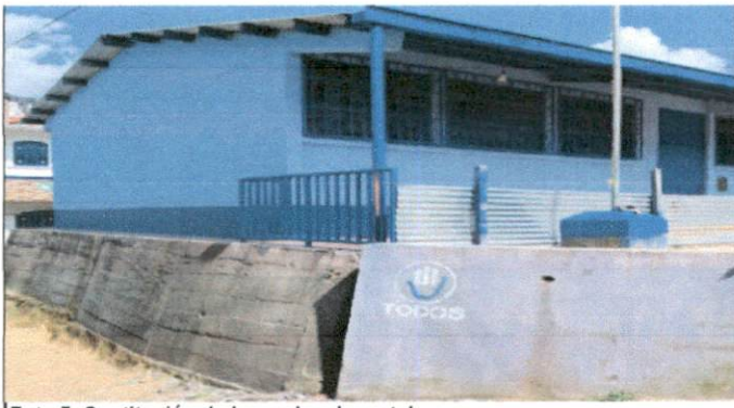
Foto 5: Sustitución de barandas de metal.
