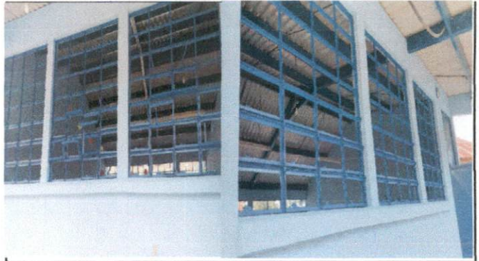
Foto 2: Sustitución de vidrios
