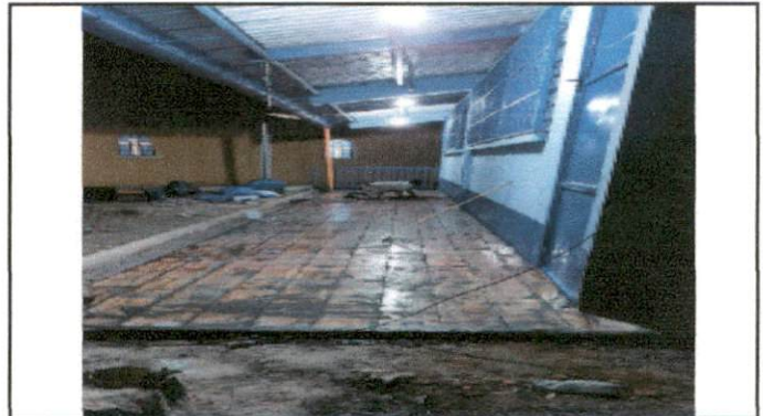
Foto 4: Sustitución de piso de granito
